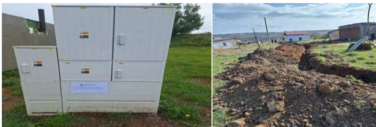
Výkopové a pripojovacie práce- elektrické prípojky v lokalite obce Kamenica
